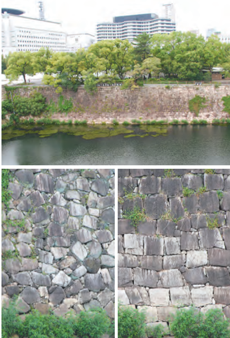
⑤55mに渡って崩れた石垣部分 ⑥修復された部分と⑤崩れなかった部分で積み方に違いがみられる
