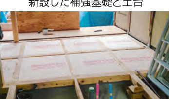
造り直した床組みに断熱材を充てん
